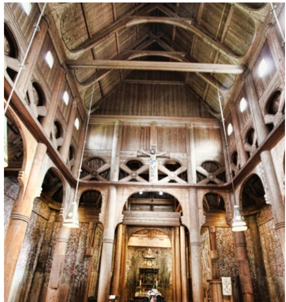
interior stavkirke heddal
