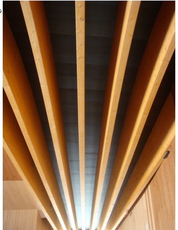
entramado de vigas
